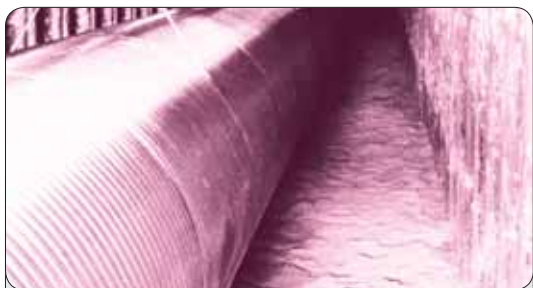
▲ در زیر زمین: در GEO ۶۰۰ باریکه‌های نور در لوله‌های فولاد و ضدزنگ شیاردار به قطر ۶۰ سانتی‌متر و دیواره‌های به ضخامت ۰/۹ میلی‌متر (راست) در زیر زمین حرکت می‌کند. این دستگاه در مقابل ارتعاش محافظت و کاملاً تخلیه شده است.
